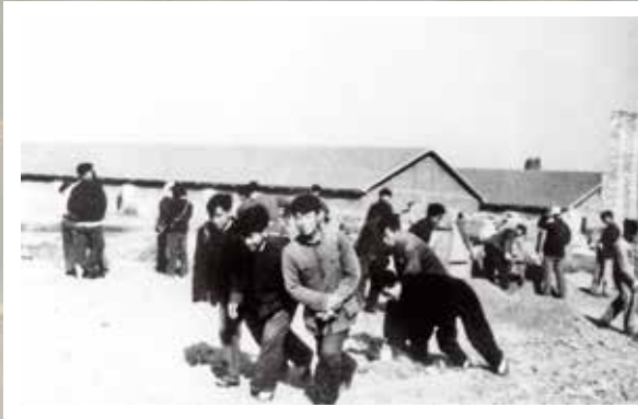
1956年，洛阳玻璃厂开始兴建时的火热劳动场面
